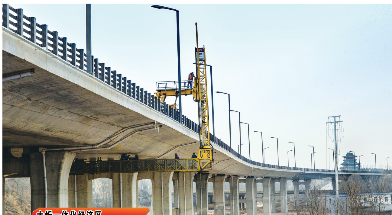
太忻一体化经济区 强势起步进行时 1月17日,太忻大道黄寨大桥段,工作人员正在对桥体进行安全运行检测,为桥梁养护管理提供科学依据。 牛利敏 宋卫东 摄
