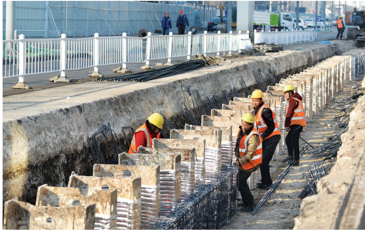
2月26日,兴华街周边排水系统及道路园林景观提标改造工程现场,建设者们正在绑扎钢筋,为混凝土浇筑作准备。该工程建成后,将有效解决兴华街排水防涝问题,提升区域综合承载能力。牛利敏 摄
