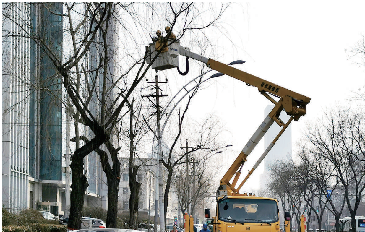
2月27日，电力工人正在对新建路上的电力线路进行树障清理，消除安全隐患，保障供电稳定。 牛利敏 摄
