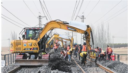
4月11日，中国铁路太原局集团有限公司大同工务段工人在大秦线27号桥进行施工。近日，我国西煤东运主要通道大秦铁路展开为期30天的春季集中修施工。据介绍，今年大秦铁路春季集中修施工将全面提升线路设备质量，为迎峰度夏电煤保供夯实安全基础。
