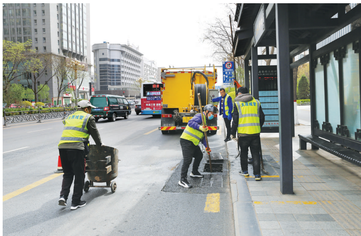
4月11日,市政公共建设管理中心工作人员在对府西街的排水管网进行春汛维护疏通,确保安全度汛。
