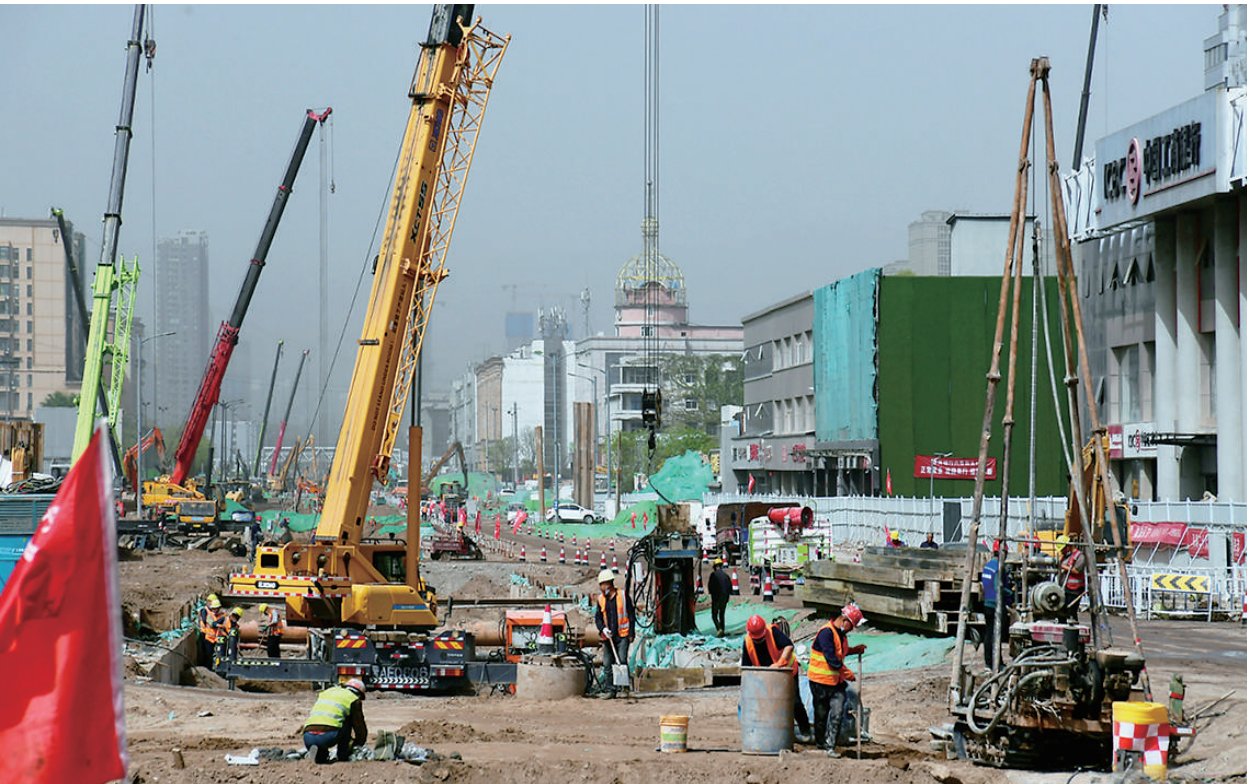
4月19日,兴华街周边排水系统及道路园林景观提标改造工程现场,一派忙碌景象。该工程经过3个多月的紧张施工,2000余米雨水方涵的埋设已基本完成,雨水泵站和调蓄池也在加紧建设。
