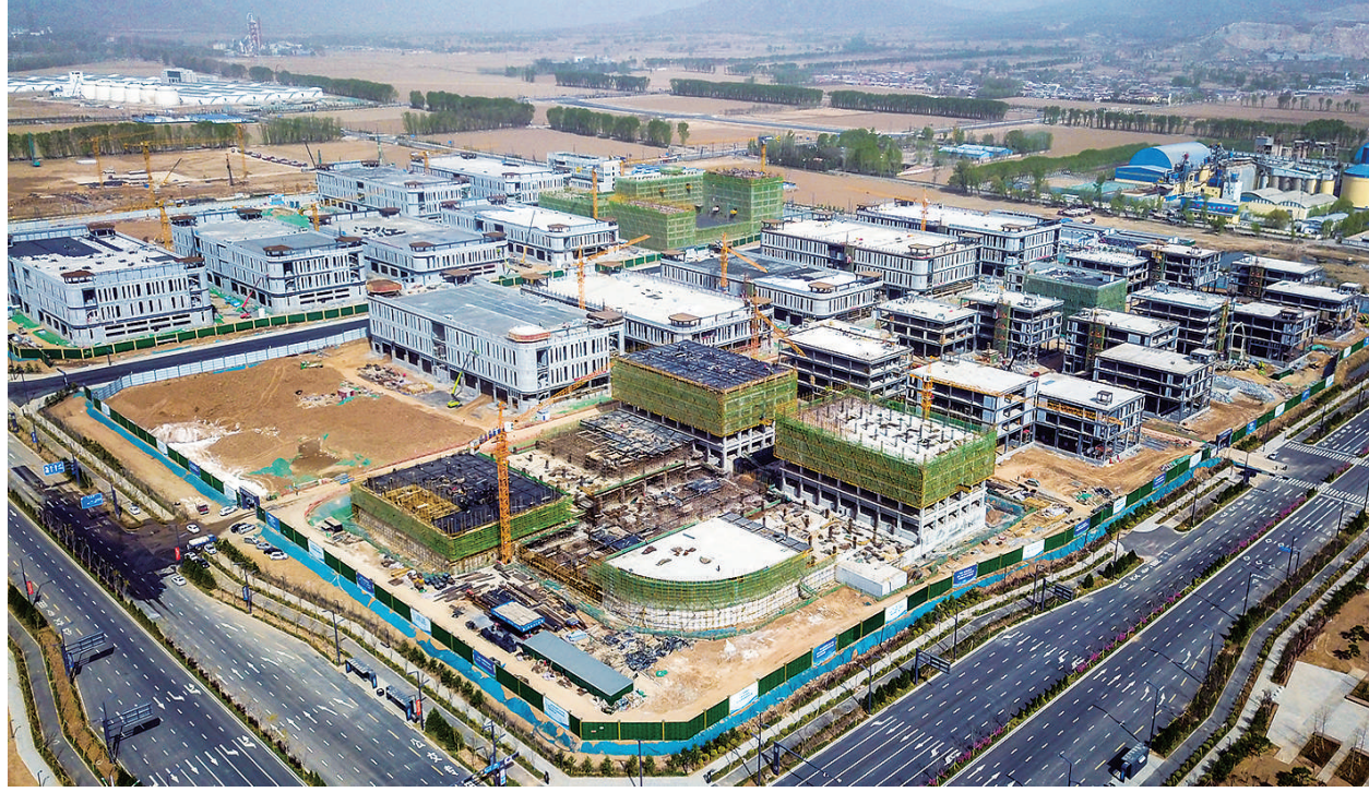
4月20日，太忻一体化经济区(太原区)配套设施建设项目(一期)标准化厂房项目初具规模。项目建成后，服务于高端装备制造、新材料、新能源、通用航空等产业。
