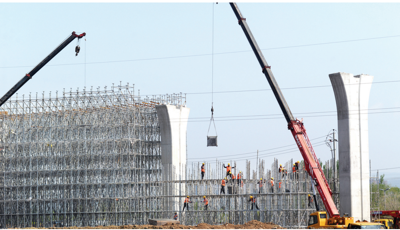
5月3日,太原武宿机场空港配套项目机场东路建设工地,施工人员正在为高架桥搭建施工平台,确保工程稳步推进。工程建成后,将增强机场的通行力,方便市民出行。牛利敏 宋卫东 摄
