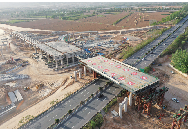
太原西北二环高速ZH11标大孟枢纽主线2号桥左幅第三联钢管梁上跨二广高速顶推施工顺利完成。
