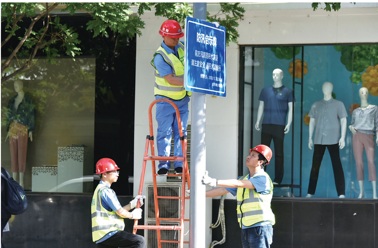
5月23日，市政工作人员为42处易积水路段统一安装防汛告示牌，保障汛期市民出行安全。牛利敏 杨斌 摄
