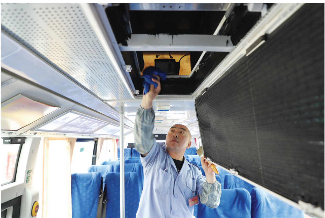
5月24日,太原公交集团电车分公司四车队职工对86路公交车的空调滤网进行清洁保养,保障乘客夏季清凉舒适。 张昊宇 史海萍 摄
