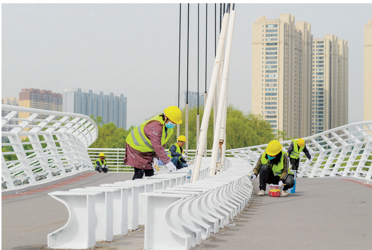
随着我市桥梁设施专项整治行动的深入开展,5月28日,滨河东路小轮车人行天桥,市政人员正在对桥体进行防腐涂装作业,以保障设施安全运行。
