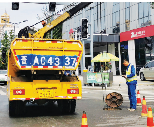
6月2日,市政人员对高新街排水管道进行清淤作业,确保安全度汛。牛利敏 摄
