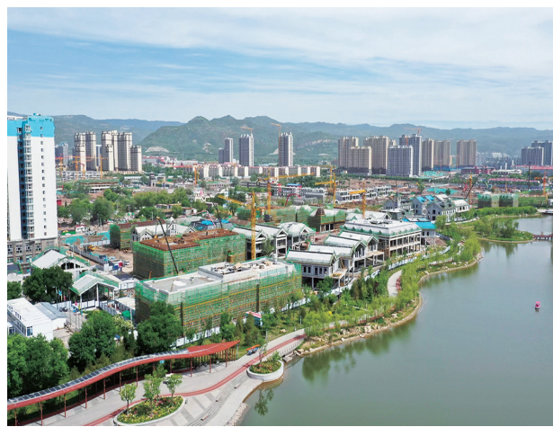
清徐县清源水城建设工程项目 图片来源于网络
