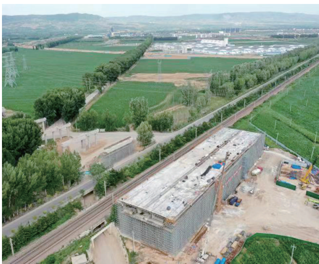
西北二环高速ZH11标上跨北同蒲铁路立交转体桥现浇梁浇筑成功。
