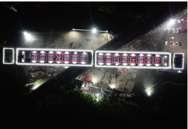
图为集大原高铁山西段首个连续梁成功转体。
