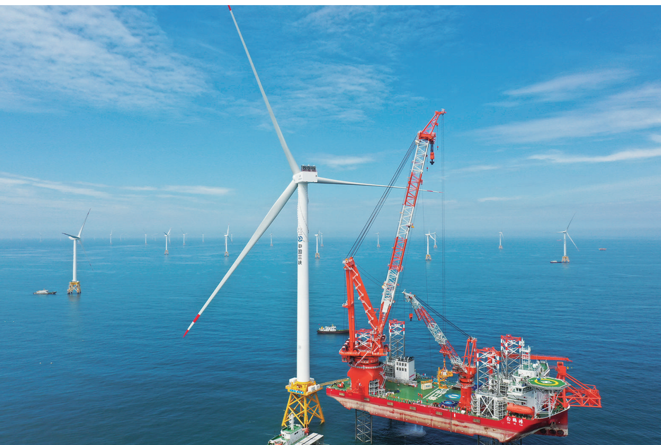
2023年6月28日拍摄的全球首台16兆瓦海上风电机组吊装现场(无人机照片)。
