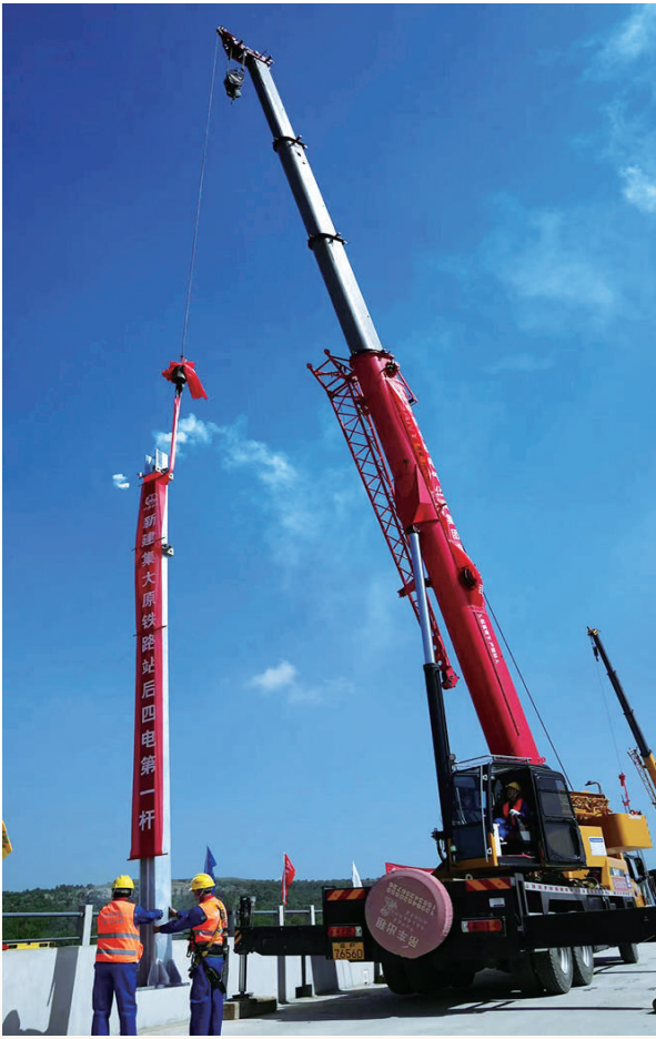
施工人员在组立集大原高铁山西段接触网第一杆。
