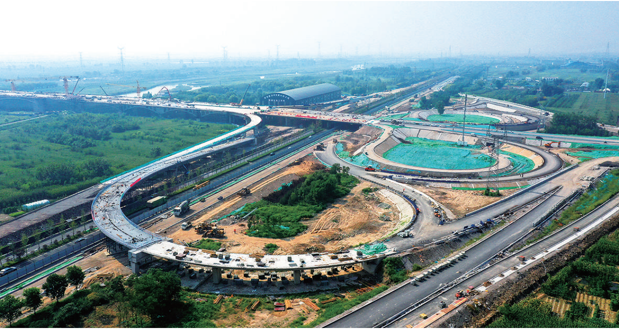
8月20日,清徐汾河文源大桥工程有序推进中。目前,该工程已完成所有下部结构(桩基、承台和墩身),主桥实现全部合龙,进入桥面铺装及匝道区的侧石安装和沥青摊铺阶段。工程建成后将成为清徐与综改示范区潇河产业园深度融合的重要枢纽。
