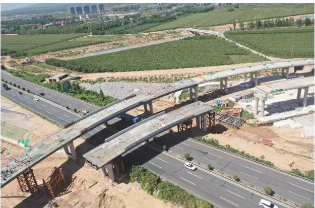
太原西北二环高速大孟枢纽上跨二广高速钢箱梁完成顶推施工。
