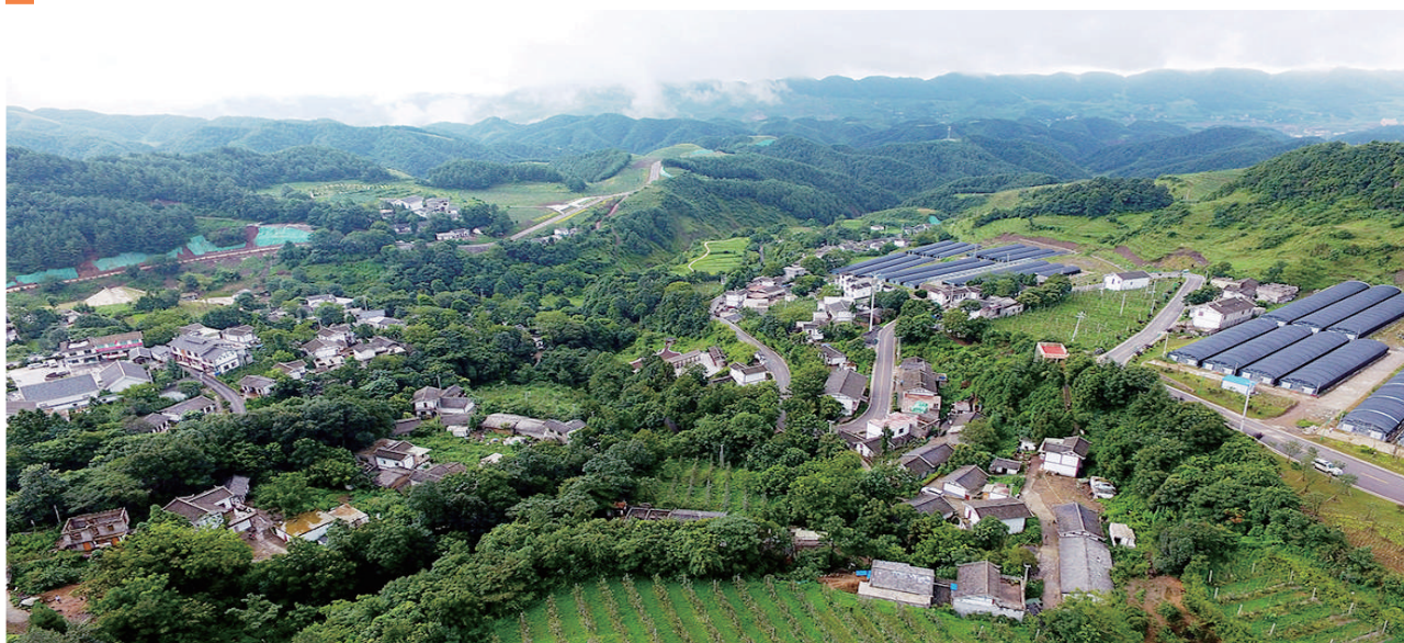
贵州省毕节市赫章县海雀村新貌(2019年7月25日摄，无人机照片)。新华社记者 杨文斌 摄
