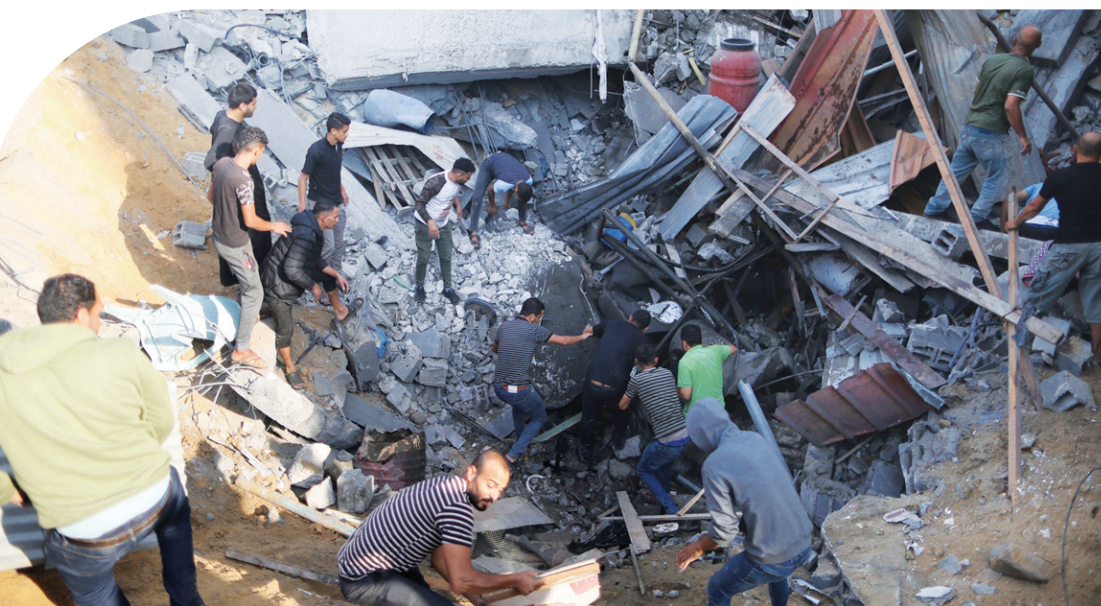
10月11日，在加沙地带南部城市汗尤尼斯，人们在被以色列空袭摧毁的建筑废墟中寻找幸存者。新华社发（亚西尔·库迪 摄）
