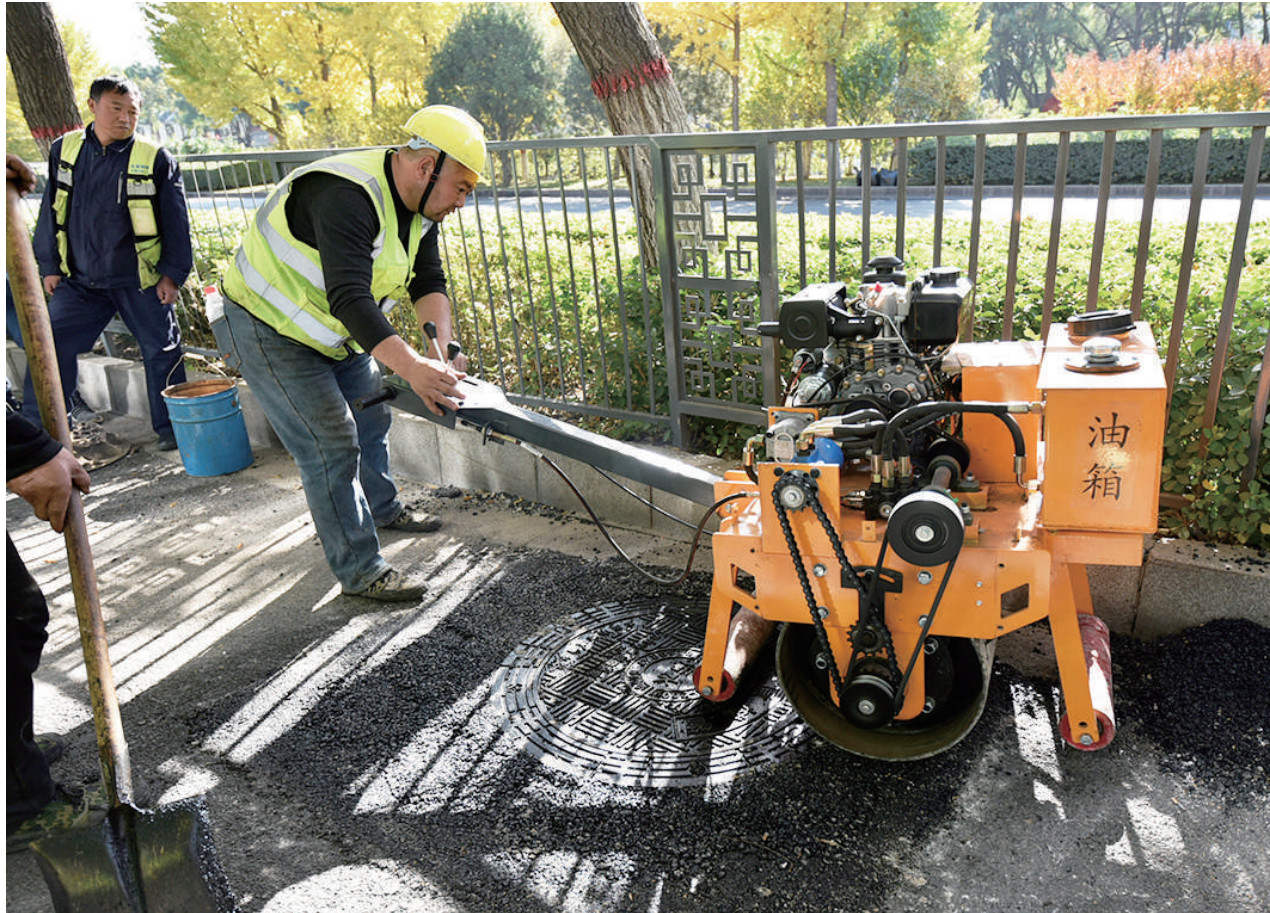
10 月 30 日,市市政建管中心的施工人员在长风街坞城路口采用新型防沉降技术快速更换损坏的井具。目前,该中心在全市范围内推进井具专项整治行动,让市民出行更顺畅、更安全。牛利敏 杨斌 摄
