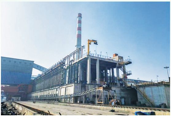
山西茂胜煤业集团有限公司的新焦炉正在生产。新华社记者王动玉摄
