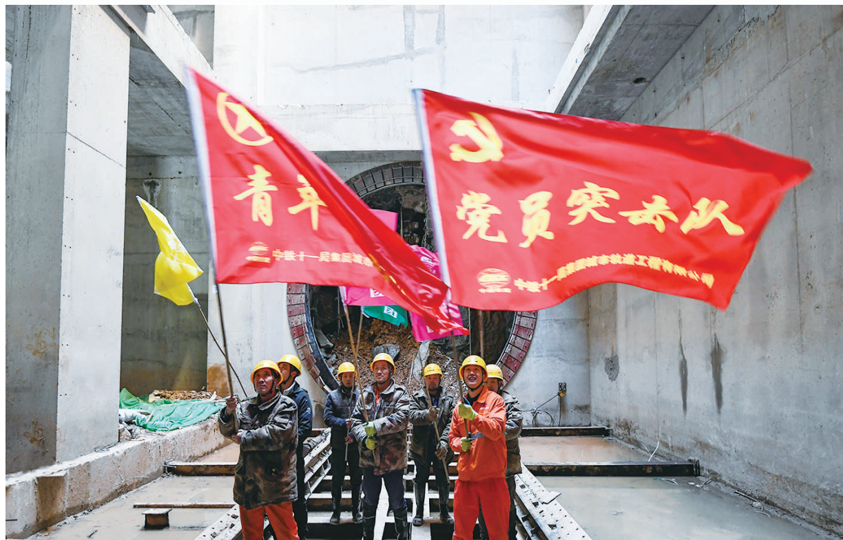
11月24日,太原轨道1号线迎泽东大街站施工现场,随着盾构机的巨大刀片旋转而出,标志着太原轨道1号线全线24个区间隧道双线贯通。
