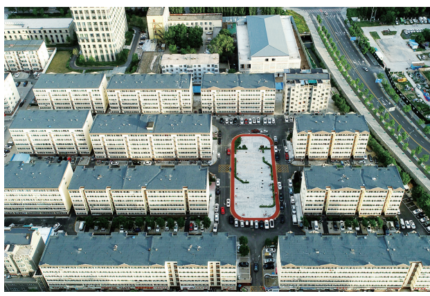
尖草坪区昌盛花园小区22栋居民楼节能改造完成，小区面貌焕然一新。 邓寅明 摄
