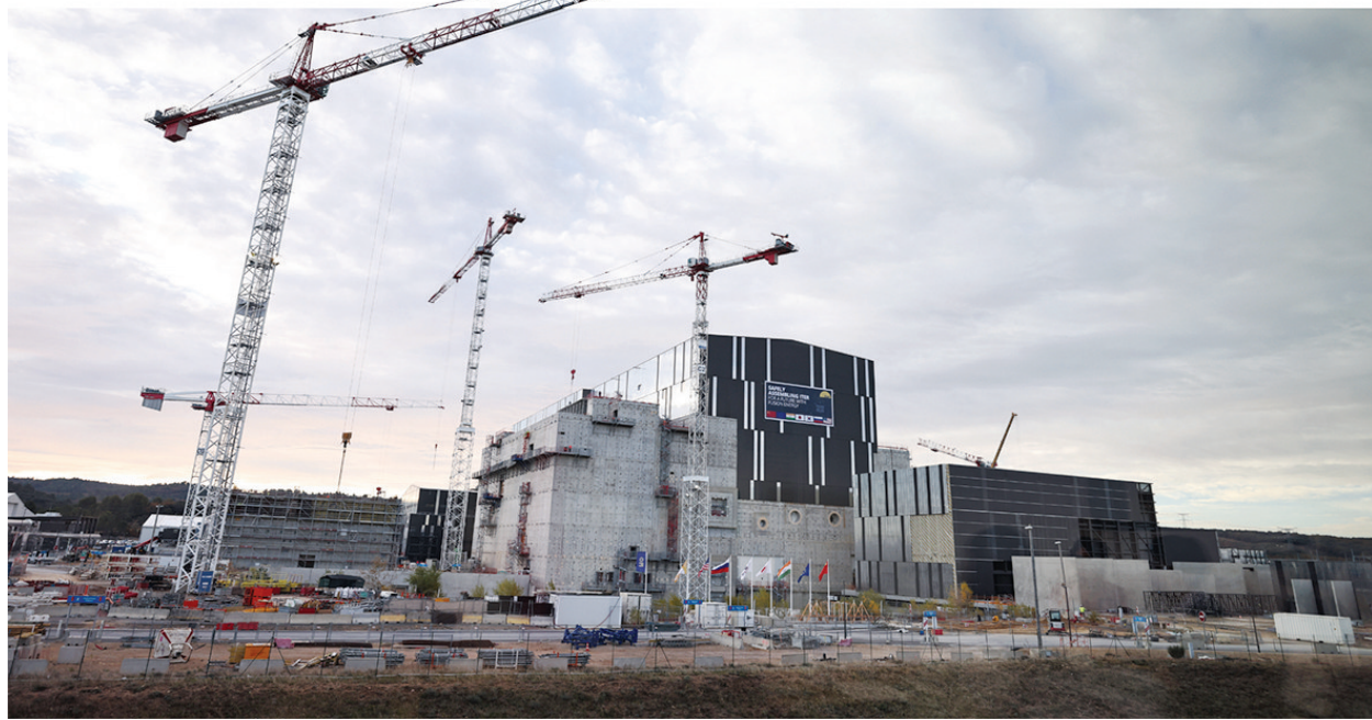
这是11月24日在法国圣保罗-莱迪朗斯拍摄的国际热核聚变实验反应堆(ITER)的建造厂房。
