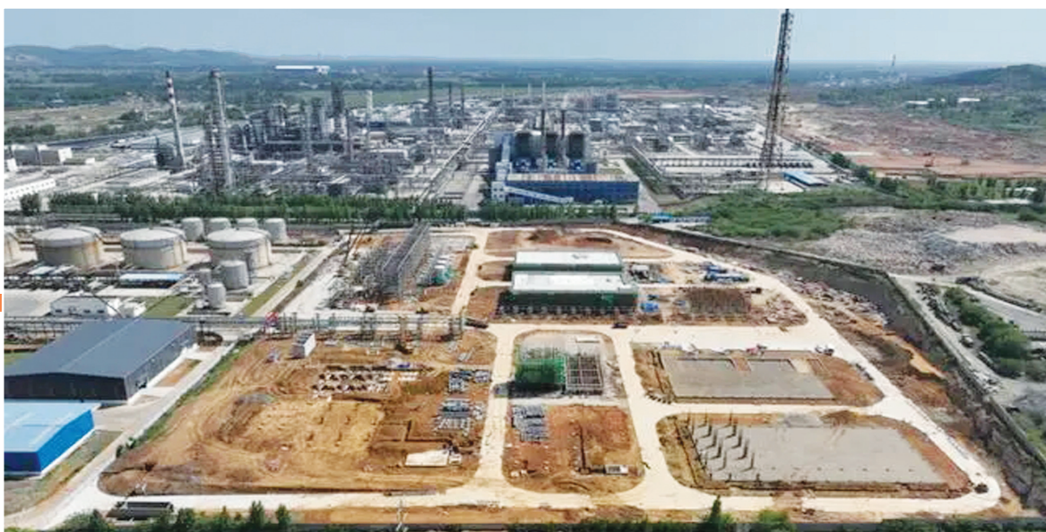
科联泓新材料新能源材料生物可降解材料一体化项目建设现场。来源：百度
