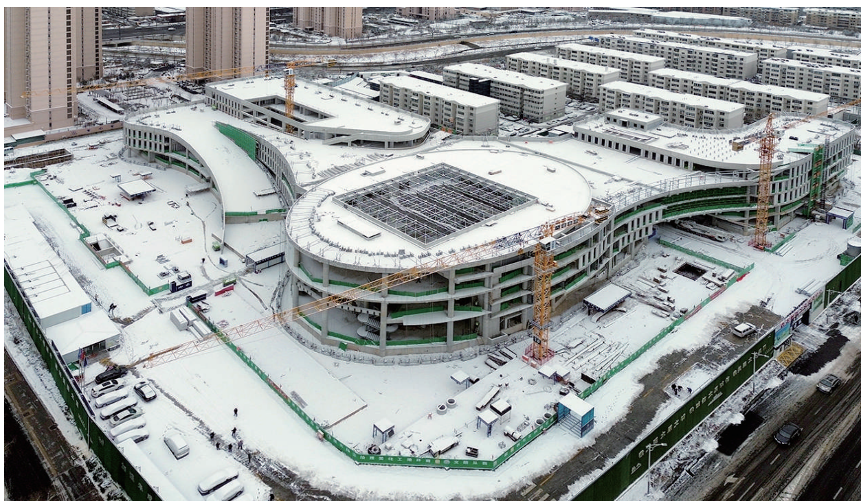
12月13日，位于胜利街的杏花岭区文化活动中心雏形初现。该项目包含文化馆、图书馆、少年宫、全民健身中心等场所，总建筑面积7.8万余平方米。目前，项目主体已封顶，内部二次结构施工已接近尾声。
