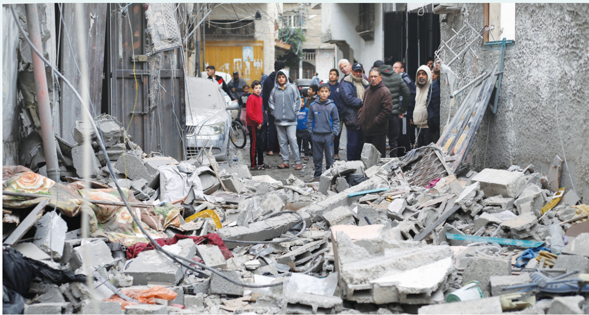
1月17日，在加沙地带南部城市拉法，人们查看以军空袭后的受损建筑。新华社发（哈立德·奥马尔 摄）
