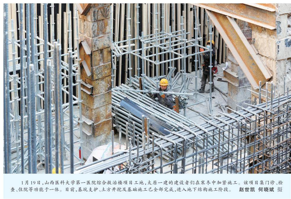
1月19日,山西医科大学第一医院综合救治楼项目工地,太原一建的建设者们寒冬中加紧施工。该项目集门诊、检查、住院等功能于一体。目前,基坑支护、土方开挖及基础施工已全部完成,进入地下结构施工阶段。 赵世凯 何晓斌 摄
