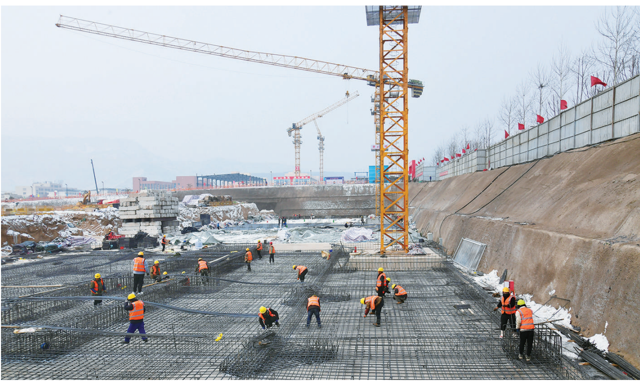
2月3日，由中铁十二局集团承建的太原高性能制造技术与智能应用升级中试基地建设工程，施工人员在作业。该项目总建筑面积21万余平方米，是集智能应用及传感器等产业为一体的综合性科技转化中试基地，也是晋创谷园区科技成果转化和经济发展的重要载体。 赵世凯 摄
