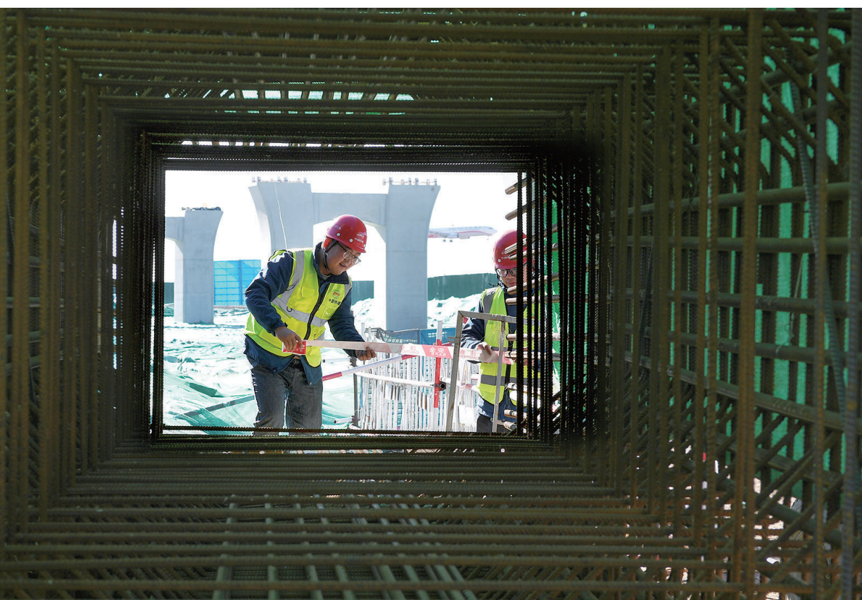
临近春节,机场周边人流量增大,2月6日,太原武宿机场空港配套项目机场东路建设工地,中铁二十二局工作人员安装安全防护设施,预防行人误入工地。 牛利敏 摄
