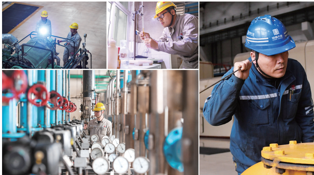
“两节”期间，大唐太原第二热电厂，“千里眼”“顺风耳”“巧手匠”等各车间的技术骨干们凭着精湛的技术巡查设备，保障机组稳定运行，守护节日中的万家灯火。
