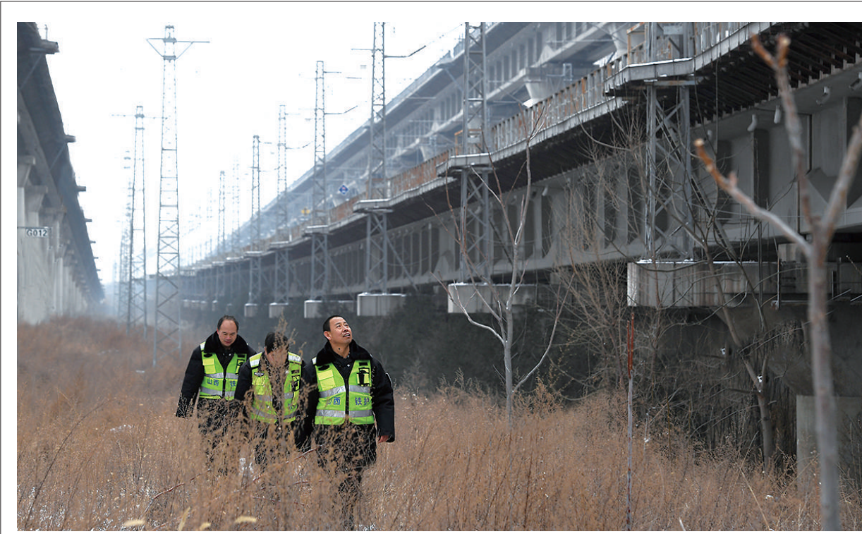
春节期间,市铁路护路联防中心加大了对我市铁路沿线的守护力度,确保春运安全。图为2月17日,护路队员正在大兴铁路尖草坪段巡线。
