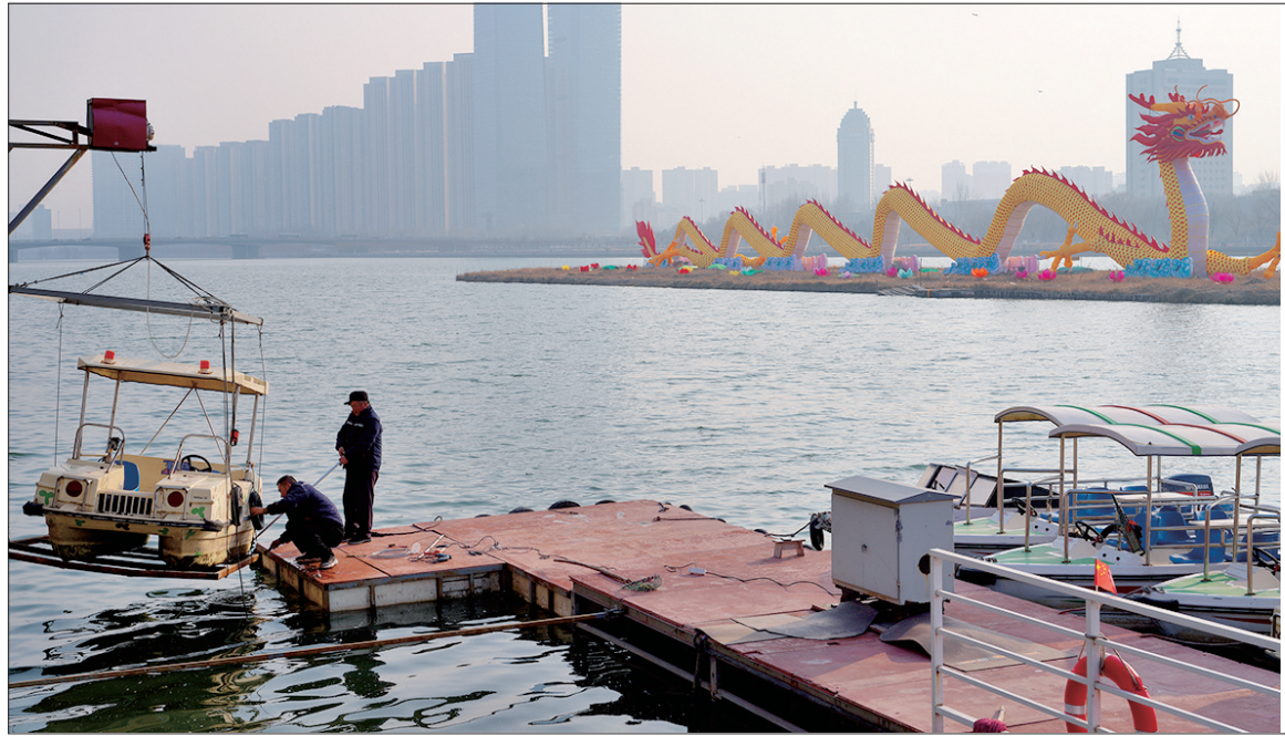
汾河景区气温回升,春意渐浓,为确保游客安全,三月七日,工作人员对游船进行检修、维护。 韩双喜 张淑宏 摄
