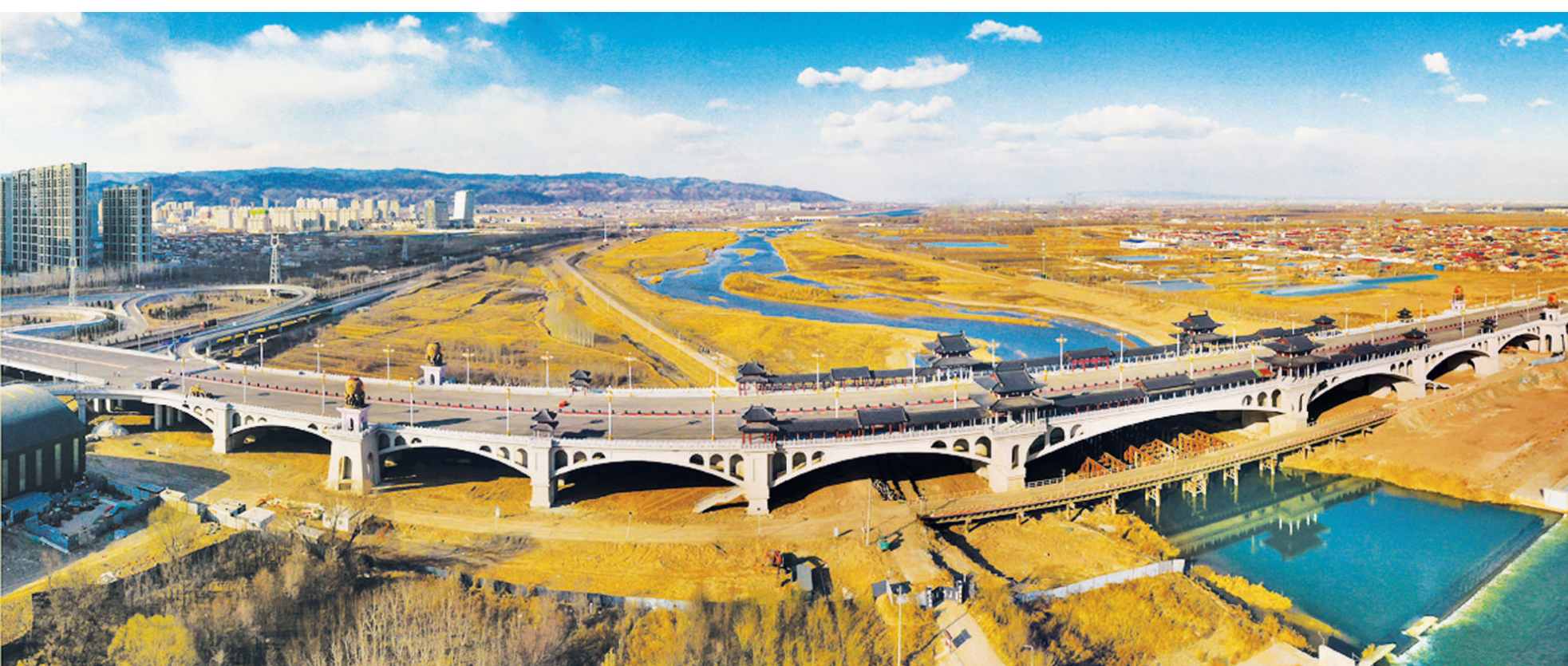
3月9日，建设中的醋都大桥桥面仿古建筑古香古色。醋都大桥全长1532米，总体布局呈拱形，平面采用船形布置。大桥设有九孔连波、观景台、迎客厅等八处景观，实现现代技术与古典艺术、汾河景观与地方文化的有机融合。 米国伟 摄
