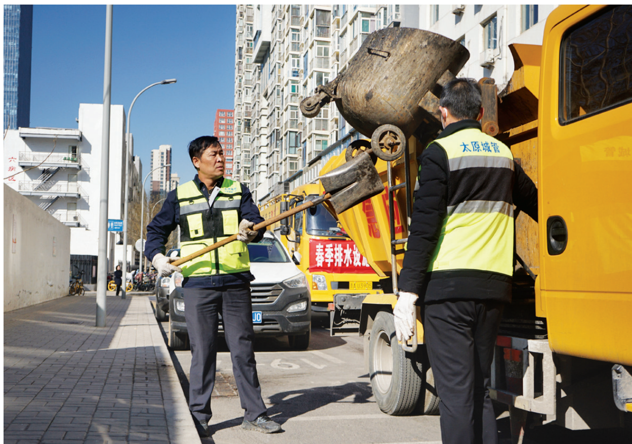
3月12日,太原市市政建管中心道路排水保障一所在杏花岭区东二道巷对市政排水设施进行清掏疏通作业。
