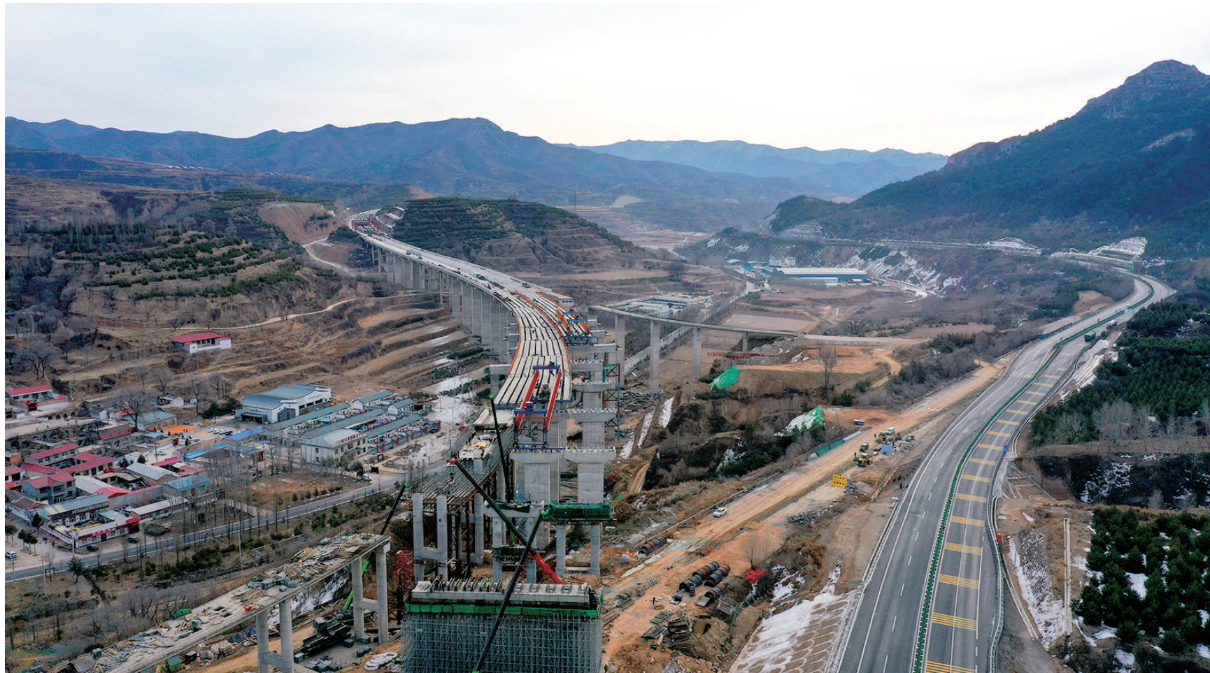
3月19日,太原西北二环高速公路西凌井枢纽至五家咀隧道建设工地,施工人员正在铺设桥面。目前,该标段工程桥梁已完成95%,隧道完成100%。 韩双喜 摄
