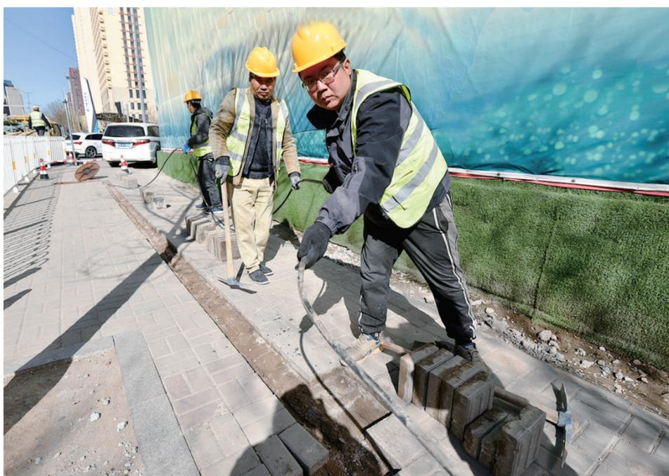
近期,太原市政建管中心针对违章掘路破路、私接线缆等行为,进行集中查处。图为3月25日,该中心稽查人员对沙沟中街和平南路口人行道上的违章破路铺设通信线缆进行拆除,恢复市政设施原状,保障市民正常通行。牛利敏 杨斌 摄影报道
