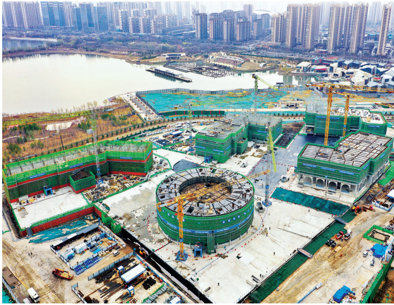
3月27日,华为煤矿军团全球总部暨山西区域总部项目(一期)工程正在加紧建设,雏形已现。该项目位于晋阳湖南岸,总建筑面积10万余平方米,建成后有效助力我市产业转型升级。王韵菲 摄
