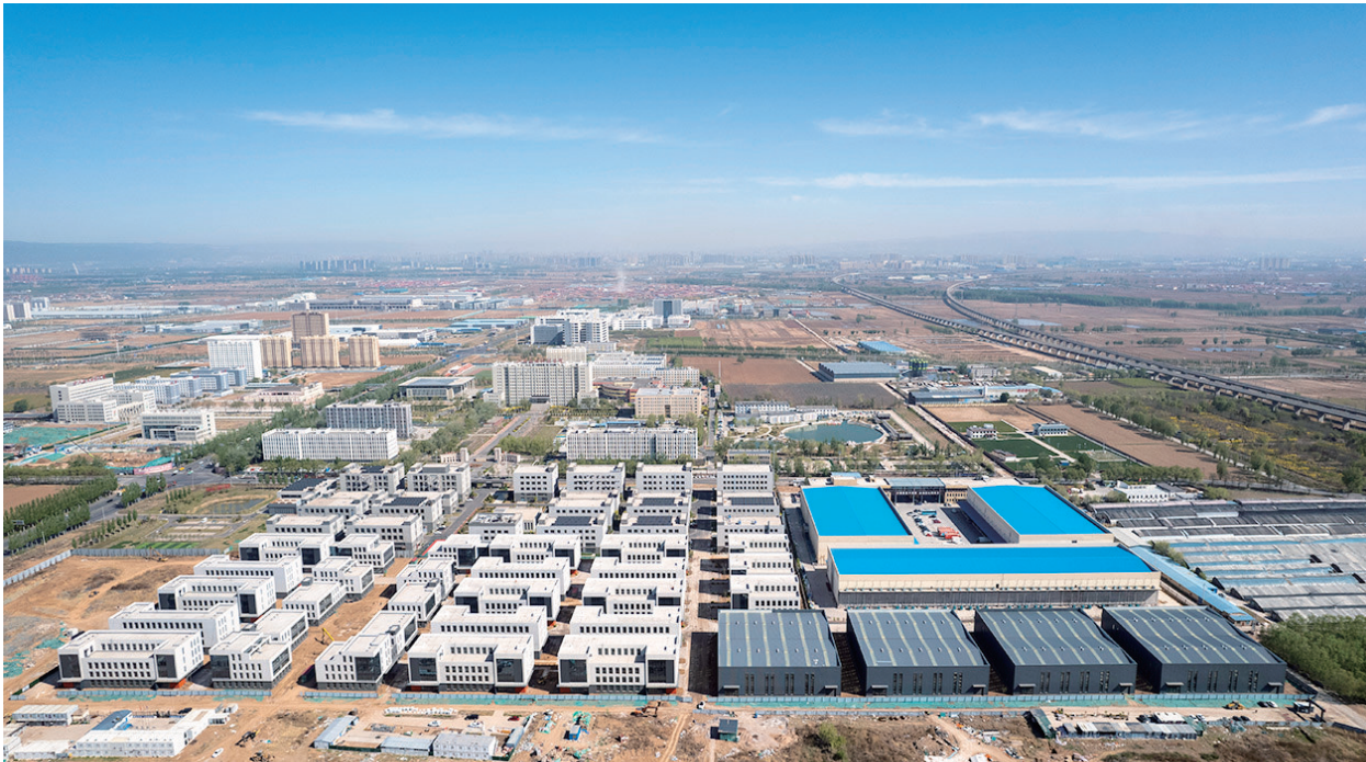
4月16日,山西转型综改示范区中小企业产业园项目建设现场,排水管道、路面硬化、设备安装调试等收尾工作有序推进。该产业园重点围绕智能制造、信息技术、健康医药等产业,为企业提供“零故障、低成本、高效率”的商务环境。王韵菲 摄
