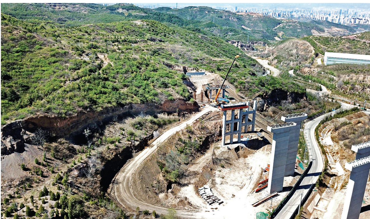
4月21日,青银二广高速公路太原联络线ZBLJ3项目麻地沟大桥施工现场,工作人员在搭建桥梁墩柱。太原联络线高速是山西省融入京津冀、对接环渤海的重要新通道。该项目起点位于迎泽区郝庄镇东祁山村,终点对接南内环东延,路线总长10.877公里。牛利敏 宋卫东 摄影报道
