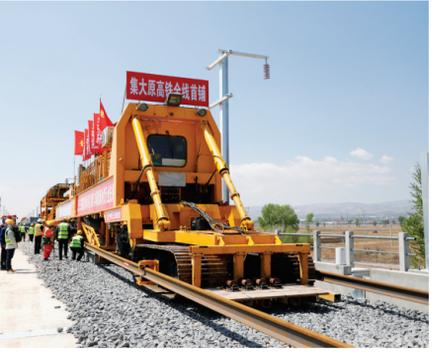
在铺轨机牵引下,集大原高铁铁轨正在铺设。
