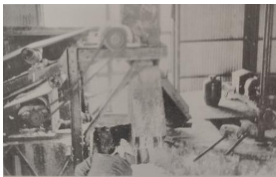
太原化学厂工人在恢复生产中修复精制搅拌装置(资料图片)
