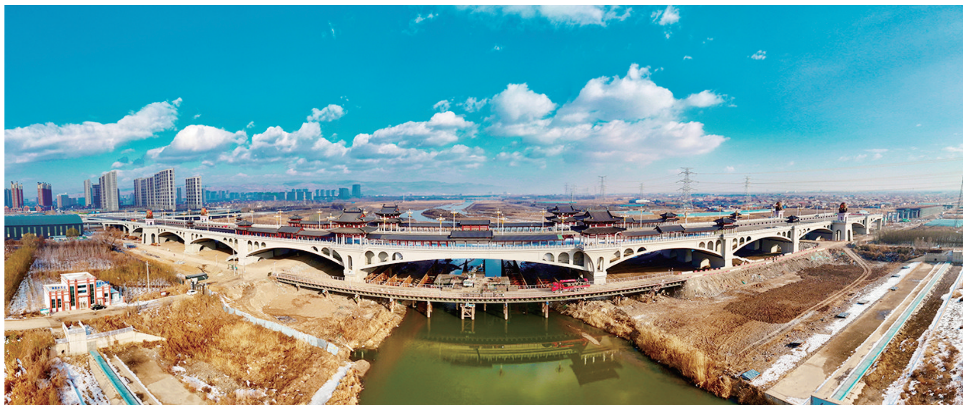
4月25日，俯瞰正在建设中的清徐县醋都大桥。该桥横跨汾河，全长1532米，总体呈拱形，平面采用船型布置，大桥设有九孔连波、观景台、迎客厅等八处景观，建筑风格古香古色，韵味十足。张昊宇 陈博敏 摄影报道
