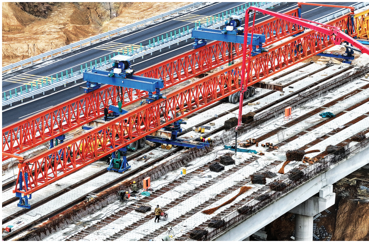
5月4日,太原西北二环高速公路西凌井枢纽建设工地,一线建设者坚守岗位,争分夺秒加紧施工,全力确保施工进度。韩双喜摄
