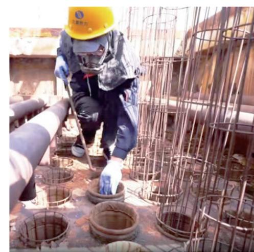
王家峰热电厂维修人员正在拆卸除尘布袋。
