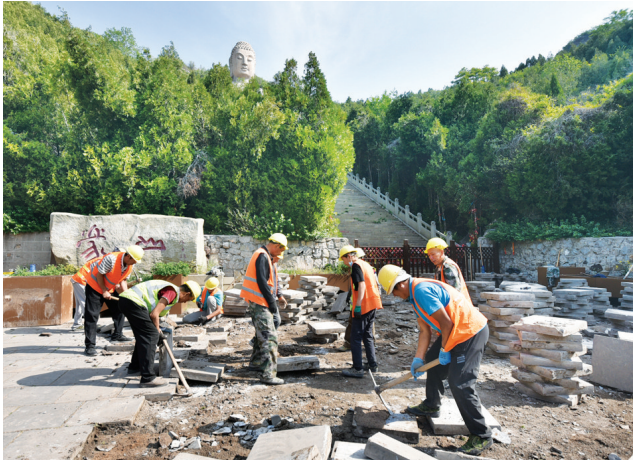
图为施工现场。
