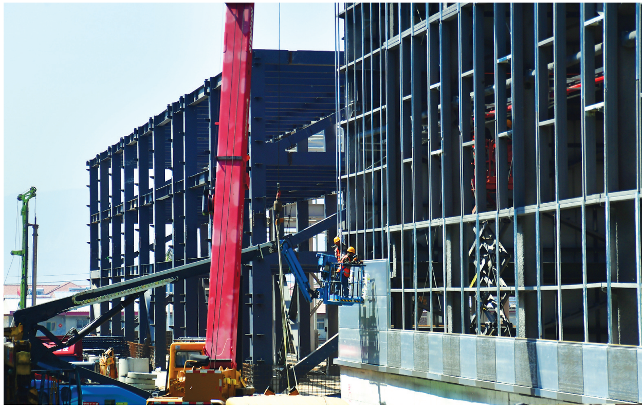
5月13日,太原高性能制造技术与智能应用升级中试基地建设项目工地,中铁十二局集团的建设者正在给钢结构厂房安装外围护。目前,该项目建设进入全面提速阶段,两座标准化厂房已收尾,传感器厂房、配套楼已封顶,总体工程量完成40%以上。
